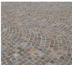
Pavimentazione in cubetti di porfido
