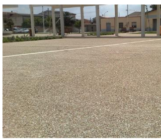
Pavimentazione esterna calcestruzzo architettonico
