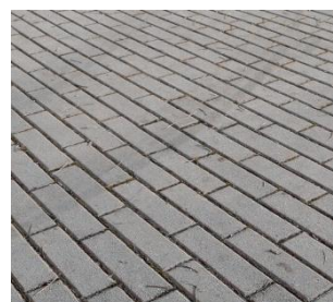
Pavimentazione piazza in masselli autobloccanti drenanti
